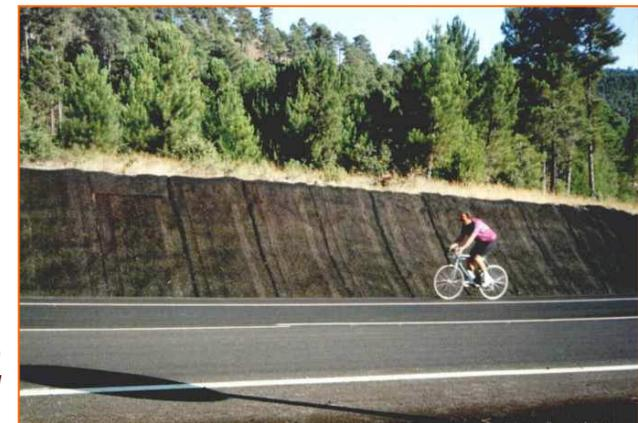
*Aspecto final de un talud cubierto con estera tridimensional*
