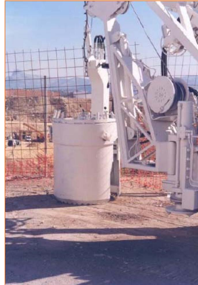
**Cilindro metálico en el que se ubica el equipo de perforación para la ejecución de los subdrenes interiores del pozo**
