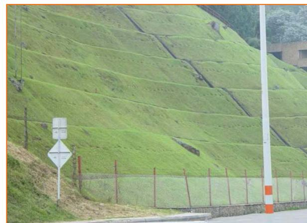
*Resultado final; muro de contención con geomalla y revegetación posterior*
