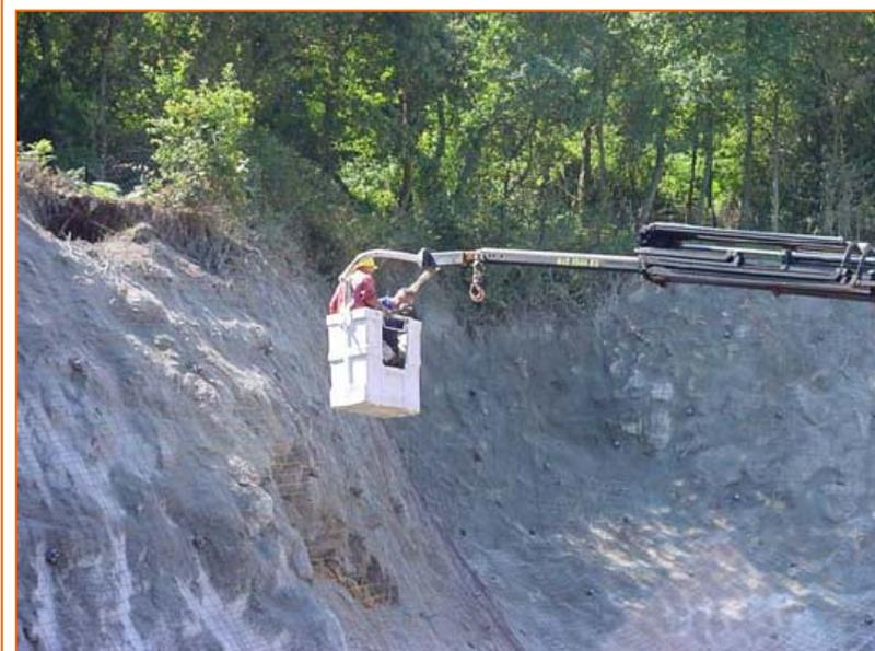
Ejemplo de aplicación de hormigón proyectado (gunita) en talud
